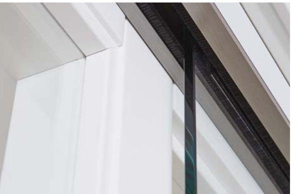
Befestigung einer Ganzglastür im Schiebetürbeschlag LINE
